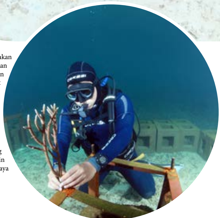
Terumbu karang buatan tersusun dari kerangka besi dan beton kubus berongga
